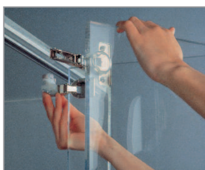
2 Zamontowanie zawiasa w szynie prowadzącej.
